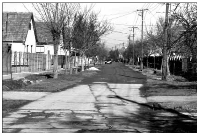
A Mátyas utca Bihar és Széles utcák közötti szakasza aszfalt útburkolatot kap és megújul a csapadékvíz elvezető rendszer is
