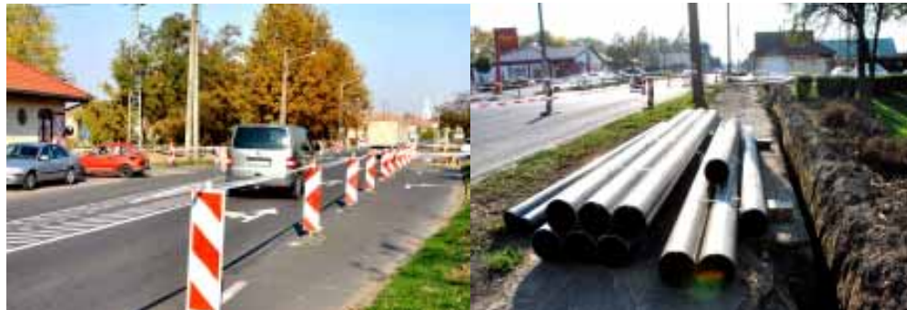
Elkezdődött a közművek kiváltásával a régóta várt körforgalmi csomópont építése a Gyulai út és az Anti út kereszteződésében
