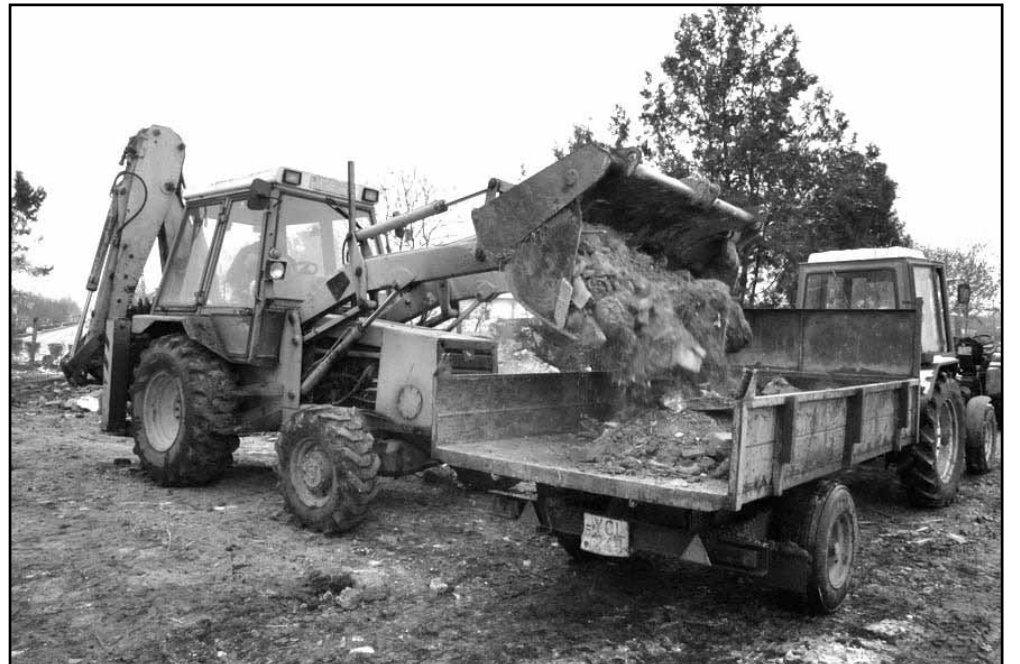
Sor került a már teljesen elaggott, omladozó csőszház elbontására és az építési törmelék elszállítására
