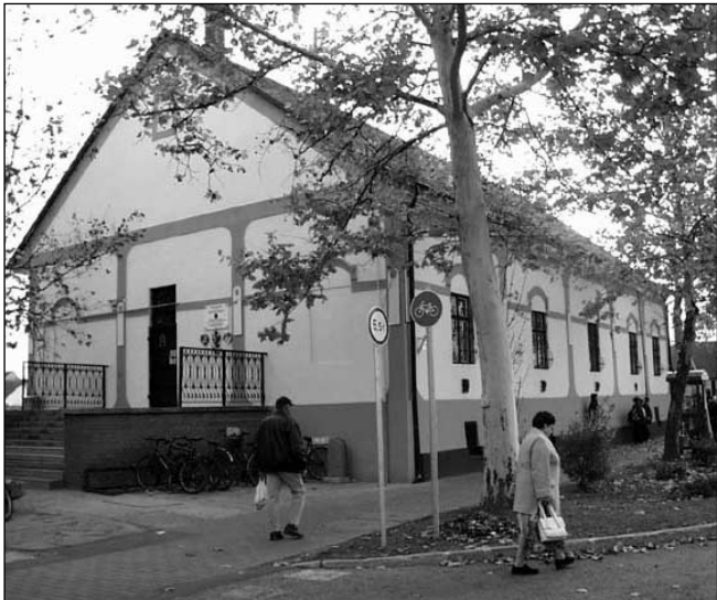
A múzeum épületének rekonstrukciójára fordított fejlesztés: 1.835.000,- Ft
