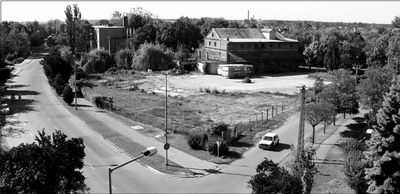
Ezen az előkészített telken épülhet meg az új kollégium
