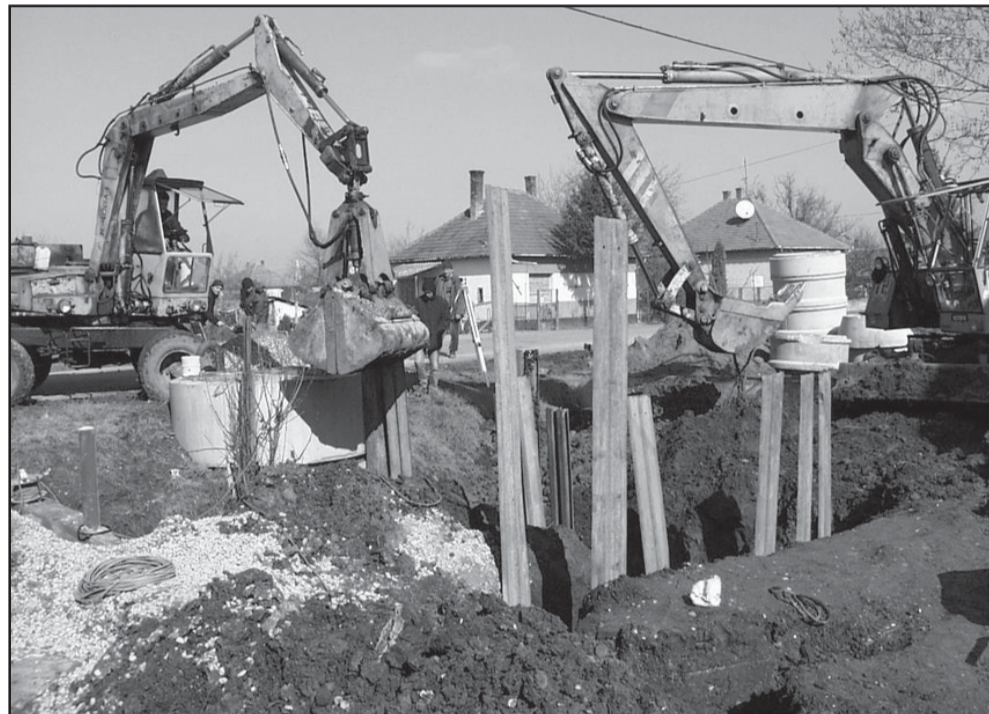
Szennyvízcsatorna-építés az Ady E. utcában 2001-ben.
