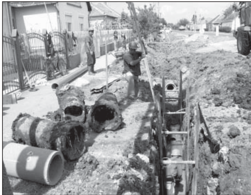
Archív kép: csatornaépítés 2004-ben a Gyulai úton
