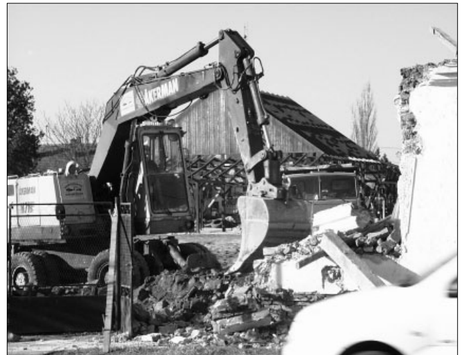
2006. december: az építési területen lakóházakat bontanak
