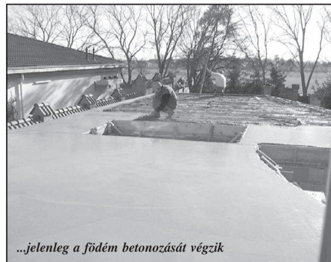
A vendégház új épületszárnya már félig elkészült...
