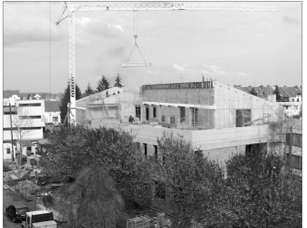
Az építők jelenleg a tetőszerkezet ácsolását végzik, az emelőszerkezet (daru) fenyegetőrendákat szállít
