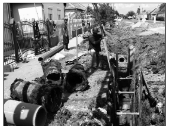
Archív kép 2006-ból: a Gyulai út csatornázási munkálatai
