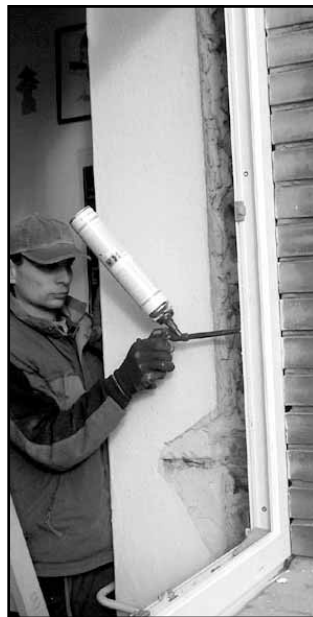
Képeink az általános iskola Kossuth utcai központi épületének homlokzati hőszigetelésekor és a nyílászárók cseréjekor készültek
