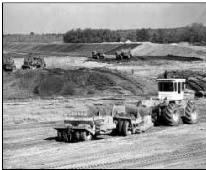
A Sarkad-Gyula-Szanazug által határolt háromszögű terület vízzáró gátjának építése. A Delta tározó a Körösök árvízi kitérésének megakadályozását szolgálja - eddig sikerrel.
