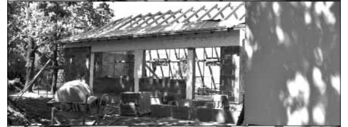
Az Epreskert utcai óvodában egy tornaszoba épül szertárral, közlekedővel
