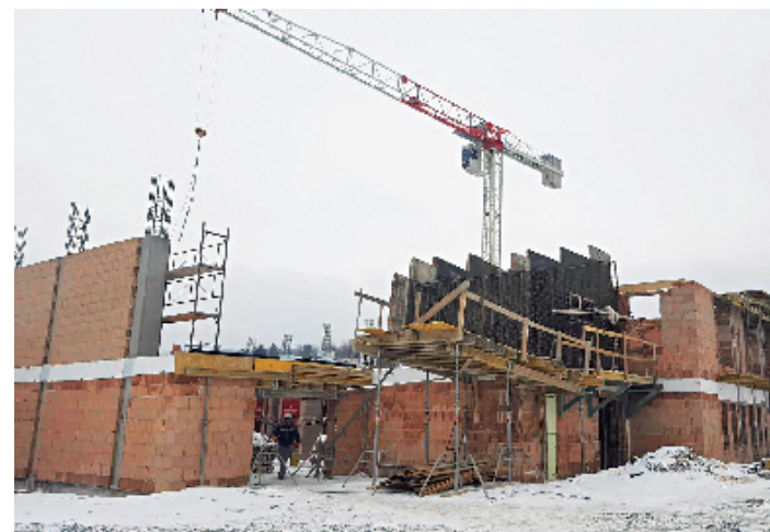
Az új iskolaépület építése
