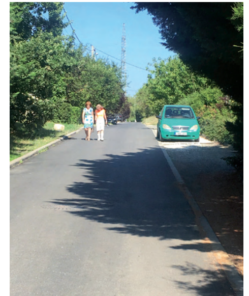
Útépítés a Kenderföld utcában
