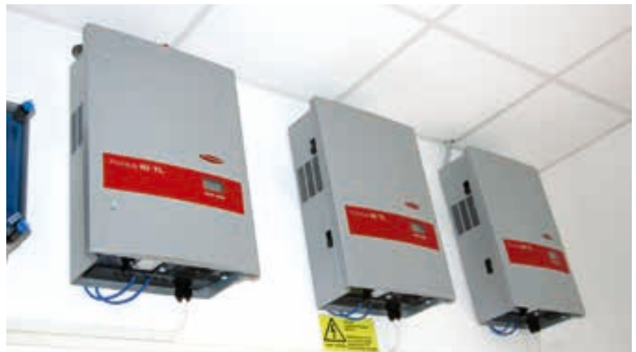
A hálózati inverterek, melyek átalakítják az egyenáramot váltóárammá
