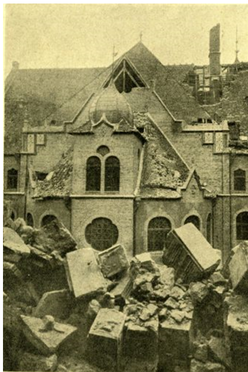
1. ábra. A városháza a földrengés után
