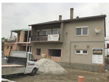
Zajlik az építkezés
