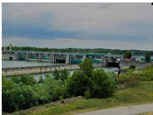
Nagy műtárgyak felújítása
