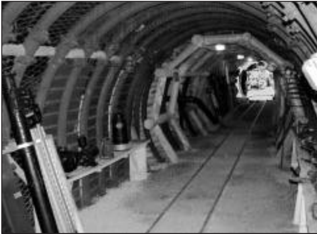
4. kép: Poligon ácsolat a Bemutatótáróban
