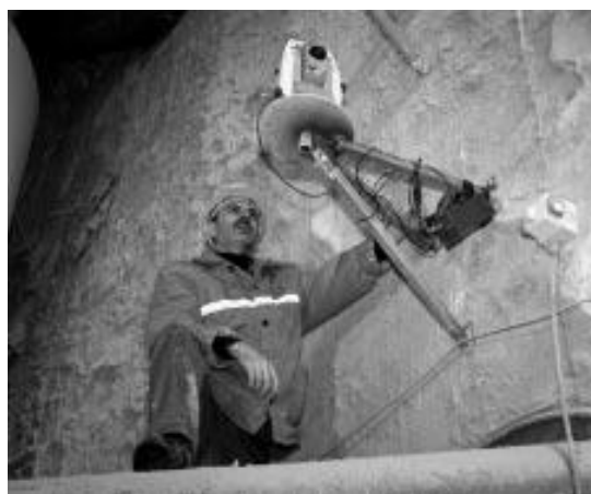
7. ábra: Mérőállomás installálás
