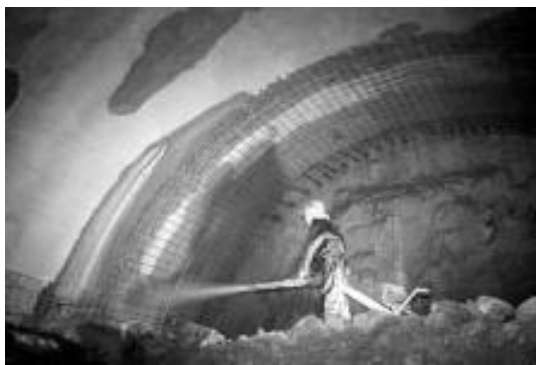
12. ábra: Löveltt beton készítés
