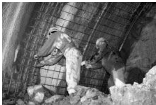
10. ábra: Hálószerelés
