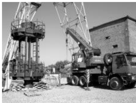
3. kép: Kétszintes munkapad beépítése
