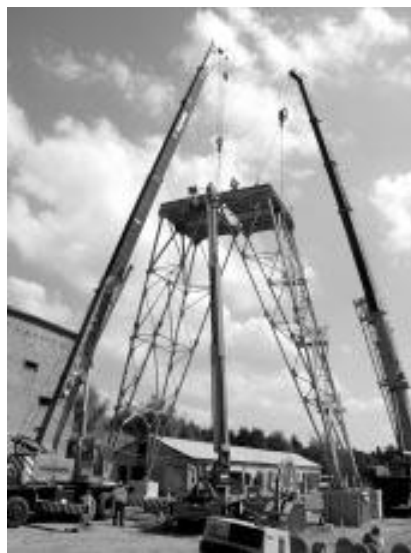
2. kép: Mátraszentimre duplex csőtorony felállítása
