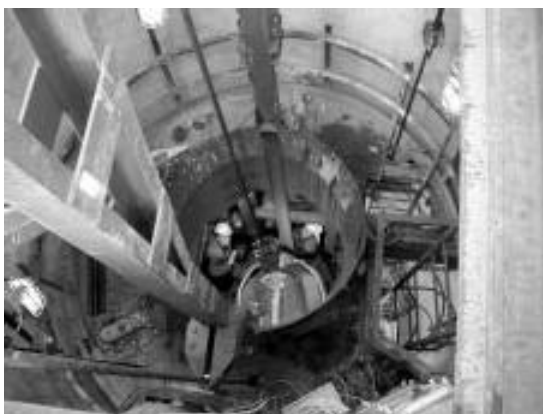
5. kép: Aknabeli munkapad villamos szerelése
