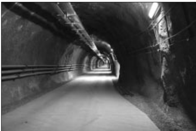
13. ábra: A szilárd burkolatú Ny-i lejtőszakna a végleges közműekkel
