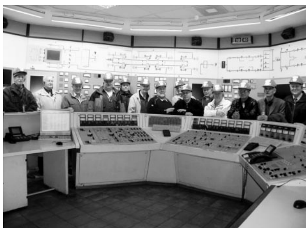
1. kép: Az V. blokk vezérlőtermében
