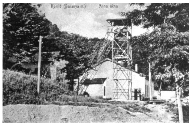
1. kép: Komló-bánya, Anna-akna vasszerkezetű aknatornya (1904-1926)
