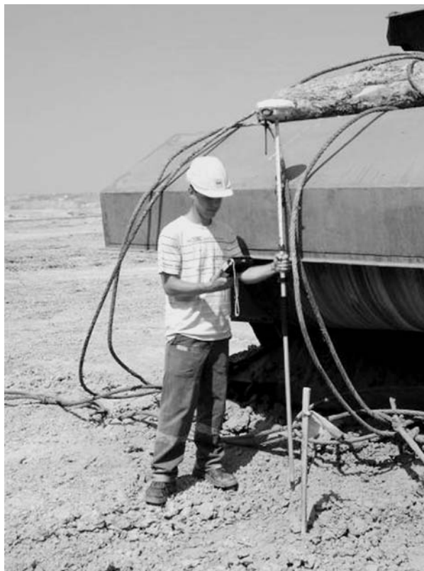
10. ábra: Szállítószalag pályájának rukkolást követő mérése
