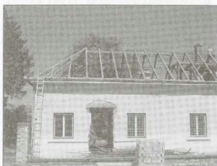
A művelődési ház felújítása is megkezdődött
