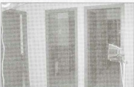
Az épülő iskolai szaktantermek
