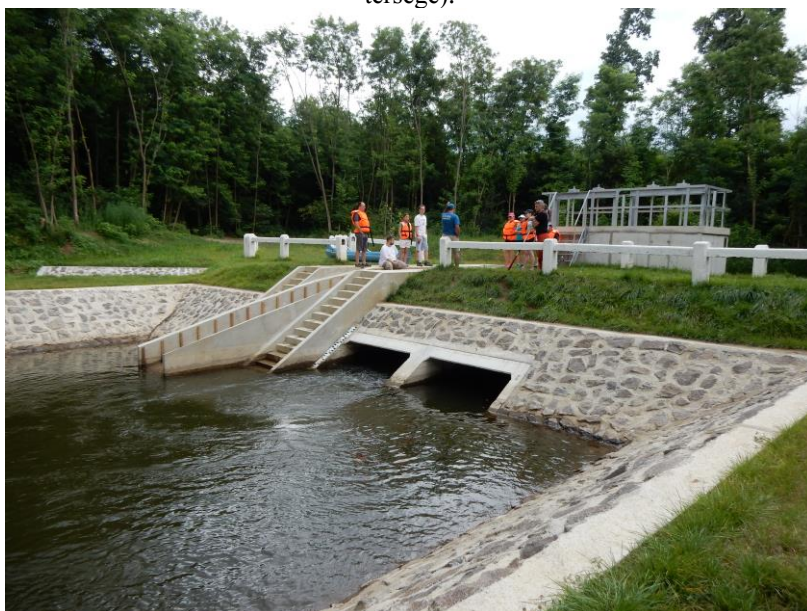
5. ábra. Ikerátereszes, zsilipes fenékgát csónakcsúszdával (Sonkád térsége).
