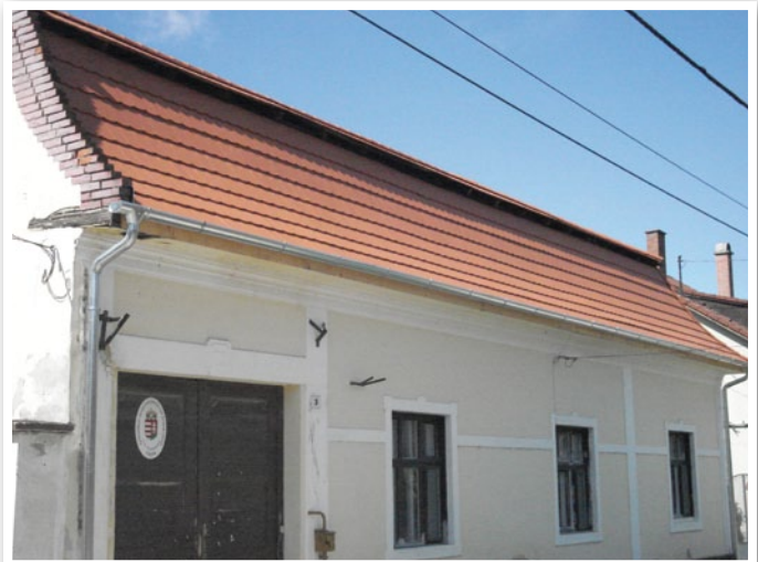
A felújítás alatt álló tagóvoda manzárdteteje már elkészült
