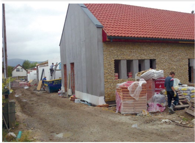
Az épülő bölcsőde
