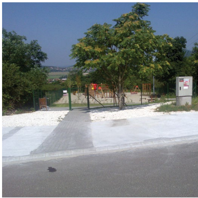
A lebetonozott, biztonságos parkolók a Rókahegyi játszótérnél
