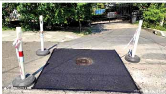
Csatorna fedlapok javítása
