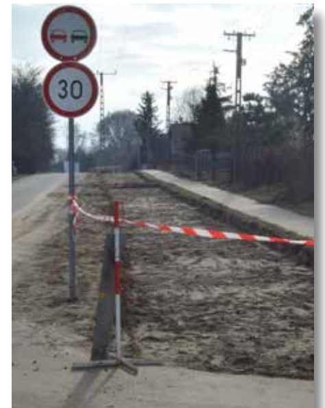
A kerékpárút felújítása és építése megkezdődött a Debreceni úton
