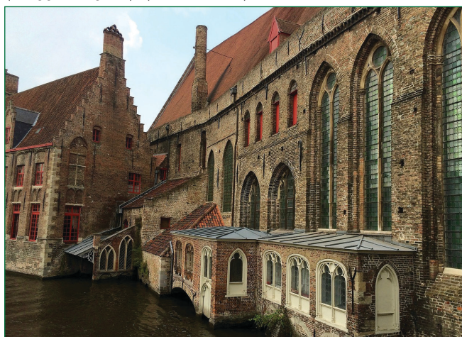
1. ábra. A Szent János Kórház (Sint-Jansspitaal) épülete (Brugge, Belgium). (Forrás: URL3)
