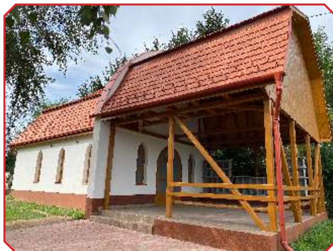
A ravatalozó a felújítás után.
