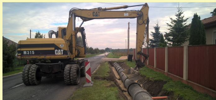
Kossuth utca alsó szakasz csapadékvíz-elevezető rendszer építése
