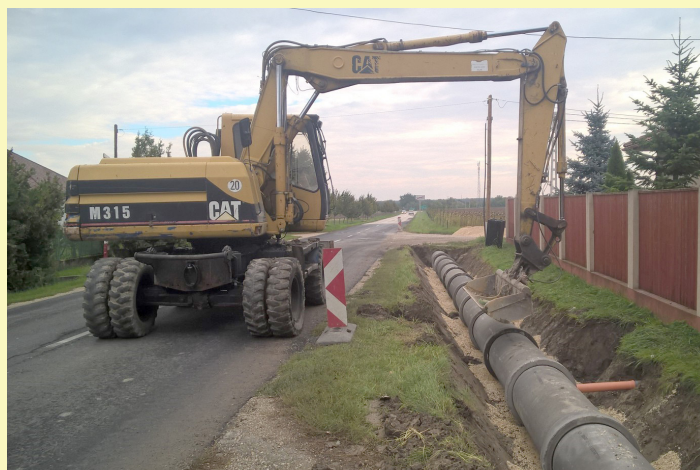
Kossuth utca alsó szakasz csapadékvíz-elvezető rendszer építése
