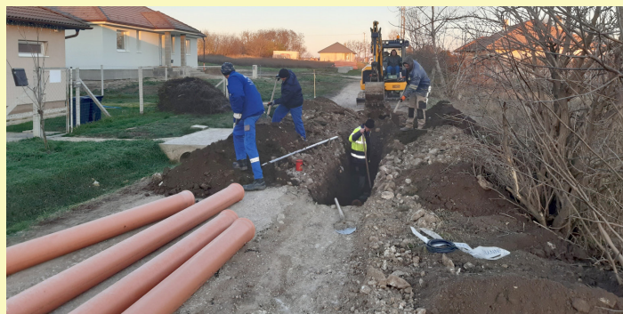
Boróka utca szennyvízcsatorna építése
