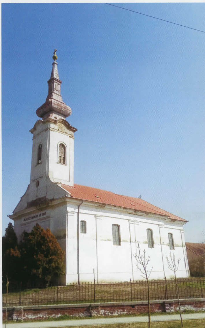
A templomfelújítás első szakasza, a tetőszerkezet felújítása lezárult
