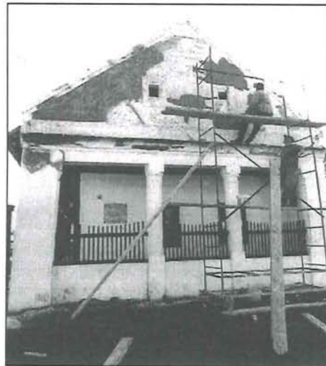
Felújítás alatt az Endrődi Tájház
