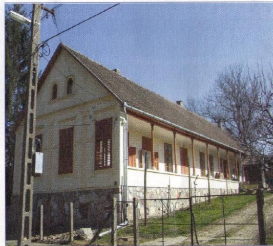
Ein frisch renoviertes Bauernhaus
