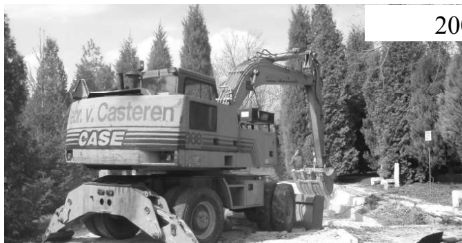
Megkezdődött a felújítás
