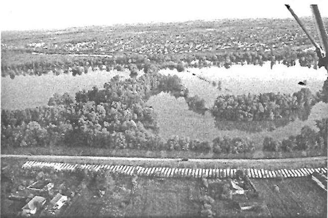
Bordás megtámasztás a jobb parton, a „cigányvárosnál”
