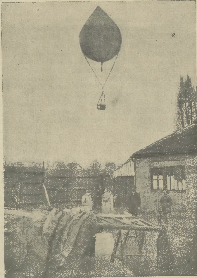
66-ik ábra. Torpedó ballon de la Hault eszméje szerint a jégfelhők szétkergetésére. (E kép a Hartleben kiadásában megjelenő „Stein der Weisen» című képes folyóiratból van véve.
