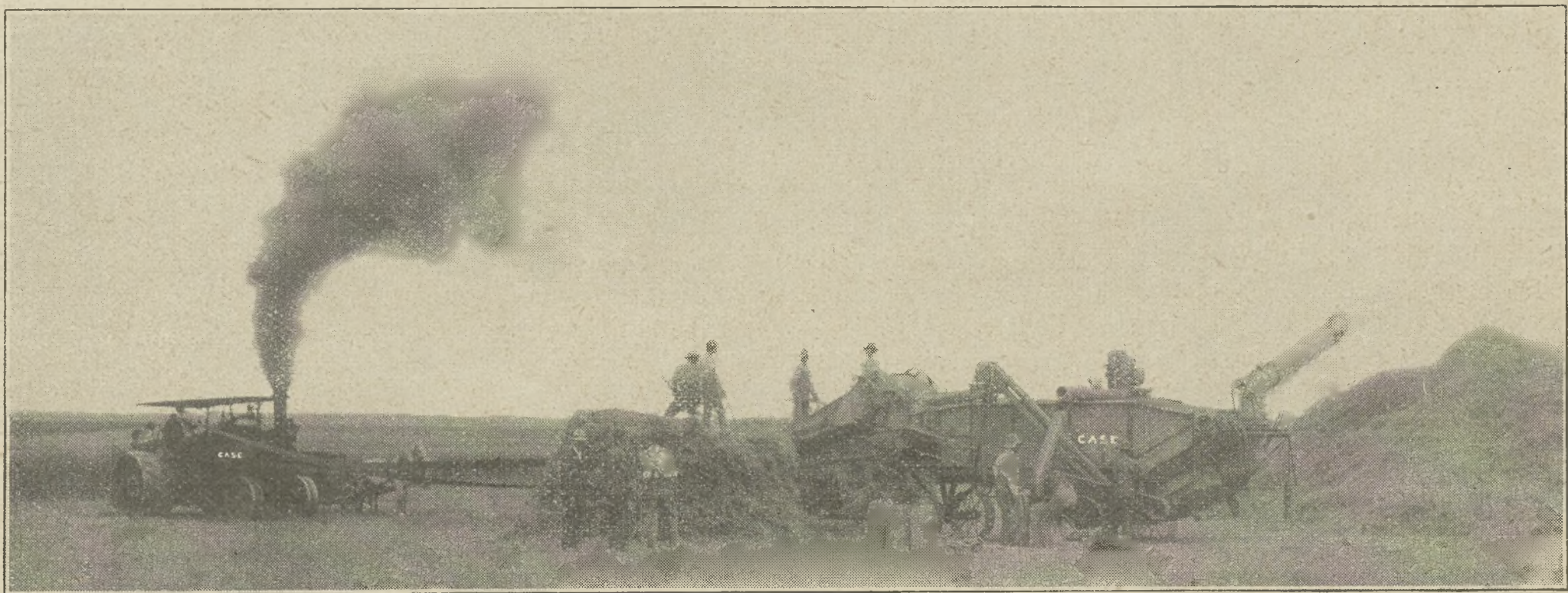
92-ik ábra. Cséplés »Case« automatikus cséplőkészlettel.
