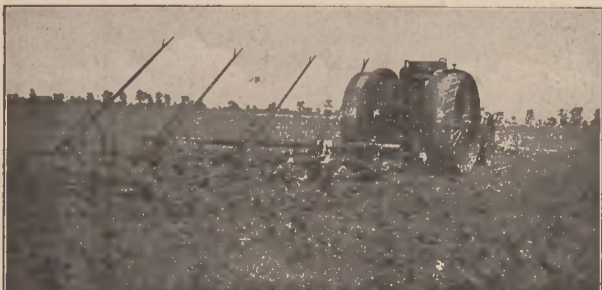
„Titán” motoros szántógépünk 8 ekével 10'' mélyen 4'' altagi lazítással szánt és boronál. (felv. gr. Niczky Ferencz osztrófasszonyfal birtokán.)
