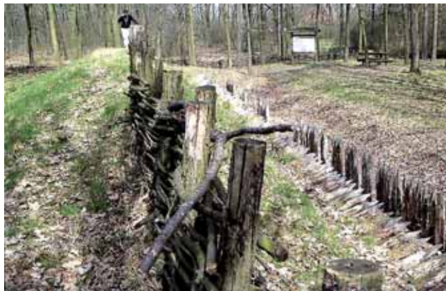
Csőrsz árok rekonstrukció Debrecennél
