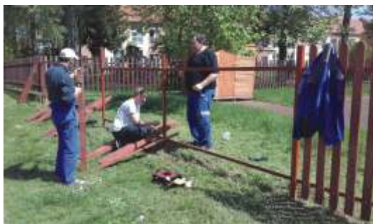
Kerítés felújítás az óvodánál.
