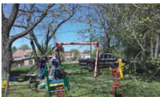
Játszóter építés a M vel dési Háznál.
