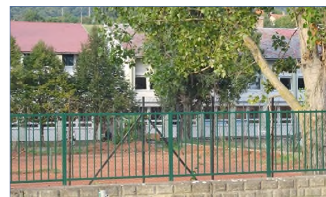
A felújított „Zöld” Iskola az Ürömbe vezető útról nézve
