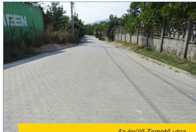
Az épülő Temető utca
