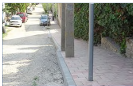
Bem utca járda és vízelvezetési munkák befejezve
