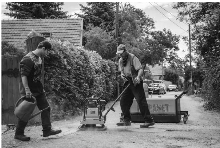
A Falugondnokság munkatársai kátyúzás közben
