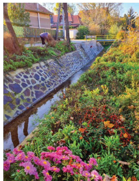
A múlt év során betonozott patakmeder a patikánál – a kivágott fák helyén őszi virágok nyílnak
