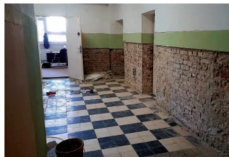
Zajlik a régi iskolaépület vízesedésének megszüntetése
