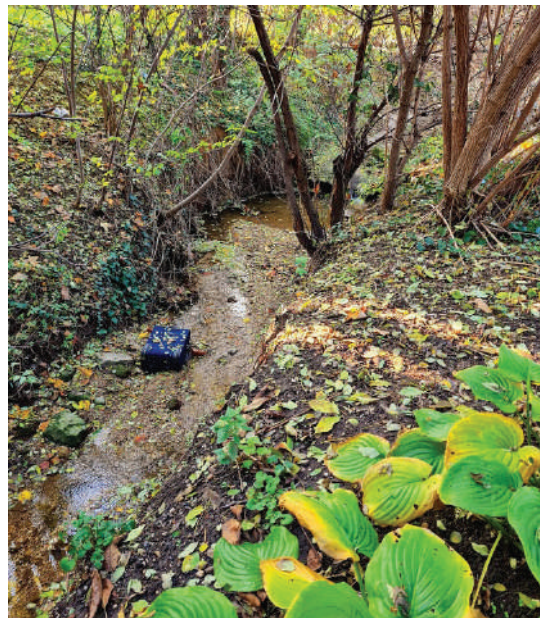
A patakmeder megerősítése is tervben van
